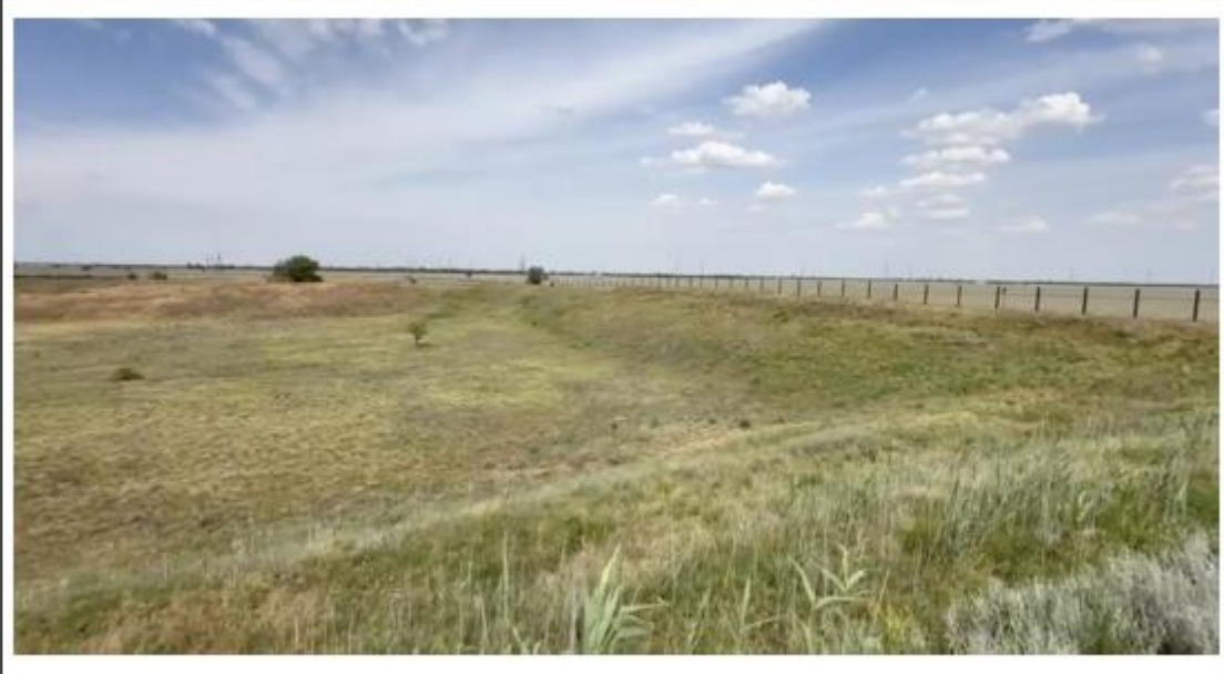
Резервный пруд-накопитель, поз.135б
